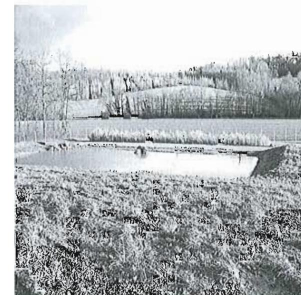
Le second étage de traitement est constitué d'une lagune de type classique qui « abat » la pollution chimique (azote, phosphore etc...) à un niveau acceptable par le milieu naturel.
