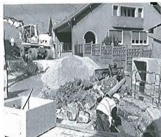
Par ailleurs, le réseau eaux usées de la rue Basse a pu être raccordé, cette fois en gravitaire, directement au réseau de la rue principale. Là, au contraire, le poste de refoulement, initialement prévu, a pu être économisé !
