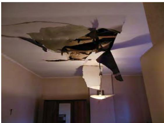
Malheureusement, si l'opération en elle-même est à présent achevée, il reste à régler la question des dégâts résultant des importantes infiltrations d'eau intervenues durant le chantier suite aux fortes intempéries et de défauts dans le bâchage
