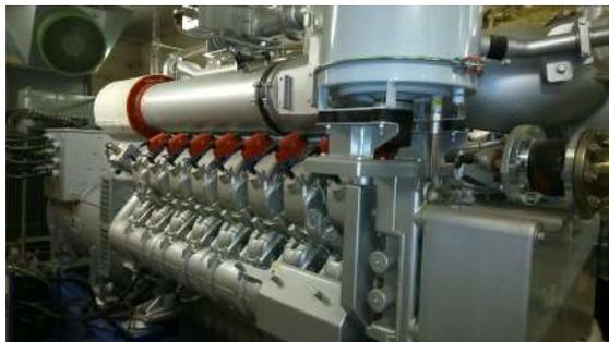
l'énergie mécanique du moteur en énergie électrique. Celle-ci est dirigée vers le **transformateur** qui va lui donner la tension requise de 17.500 V pour pouvoir être raccordée au réseau moyenne tension qui parcourt nos campagnes.
